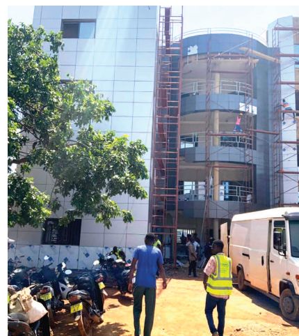
Les travaux de réhabilitation de l'immeuble qui abritera le siège de la MUTRAF doivent finir en fin novembre.
